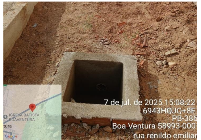
FIGURA 6.4 – Caixas de esgoto em pontos espalhados na zona urbana de Boa Ventura.
