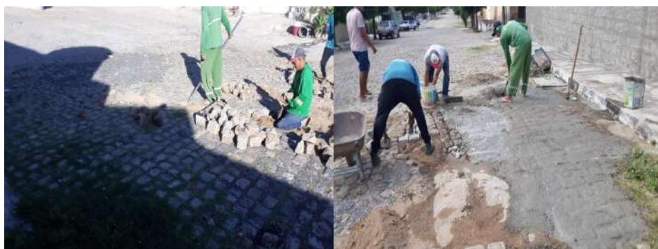
- Manutenção do calçamento na rua José soares
