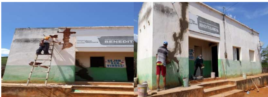
-Manutenção do reboco da escola Benedito Barbosa
