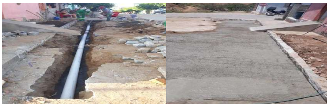
Manutenção de pontos de esgoto na rua João Estanislau
