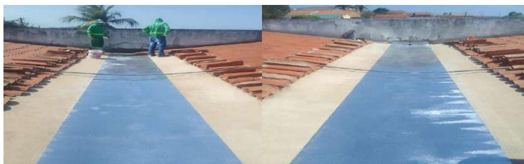
- Manutenção do telhado na unidade básica de saúde:
