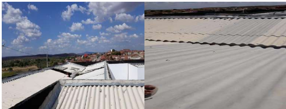
Manutenção do telhado na UBS 2:
