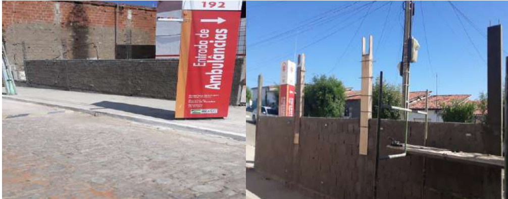
Construção de mureta para a base do SAMU
