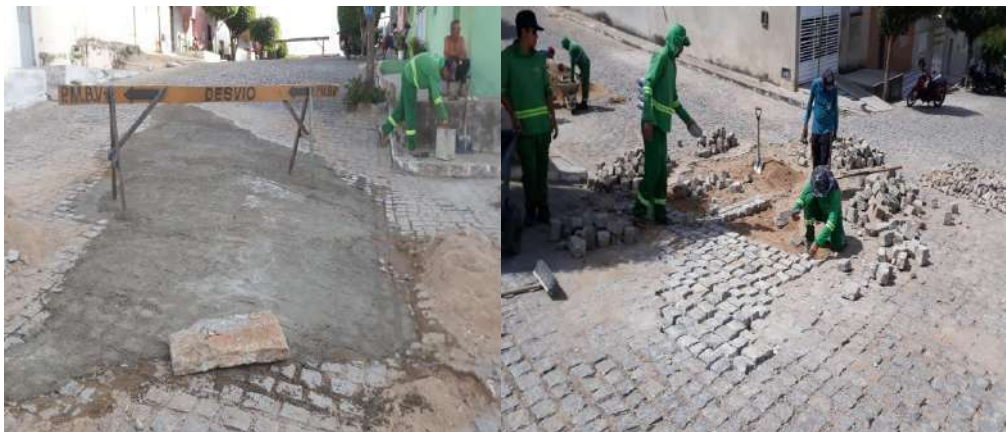
Restauração do calçamento na rua Mestre Silvino
