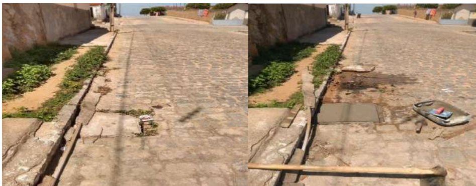
Restauração de caixa de esgoto na rua Pedro Caboclo
