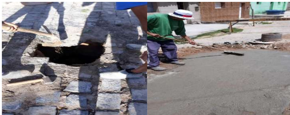
Manutenção da via carroçável na rua José Soares:
