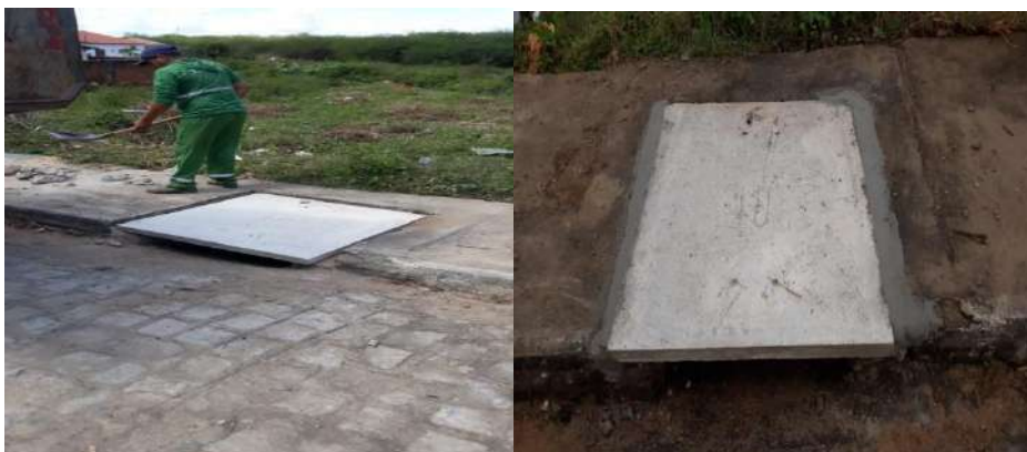
Restauração de caixa de esgoto na rua Mestre Silvino
