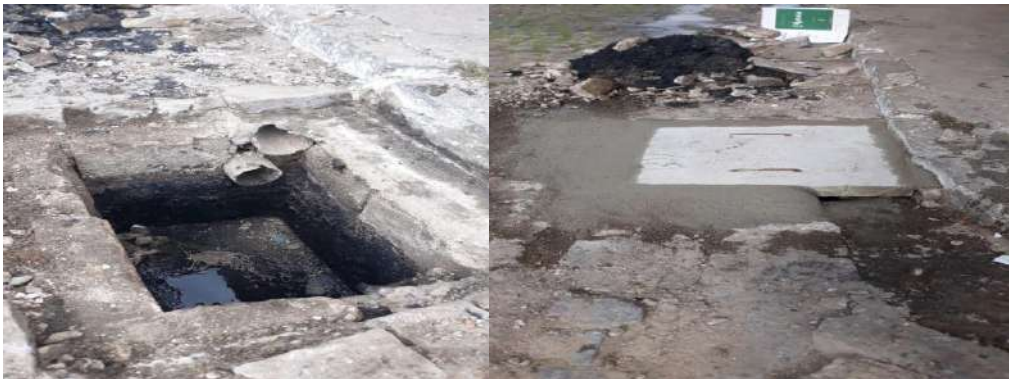
Restauração de caixa de esgoto na rua José soares
