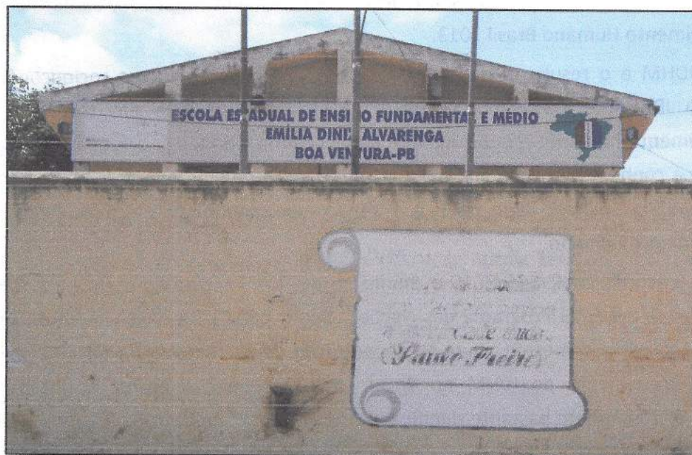
Figura 7: Escola Estadual de Ensino Fundamental e Médio Emília Diniz Alvarenga (Foto)
