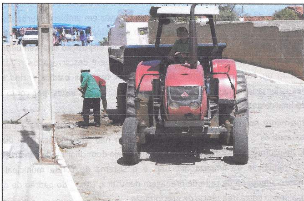
Figura 10 – Disposição Inadequada dos Resíduos da Construção Civil (RCC) (Foto)
